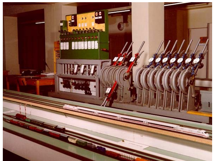
Mechanisches Stellwerk des Bahnhofs Dornbach (untere Gleise) und ICE im Eisenbahntechnischen Betriebslabor TU Dresden
